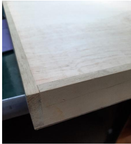
4.2.6.2. Item 02 – Gaveta de madeira da coleção em via seca de aves e de mamíferos – detalhe da junção
